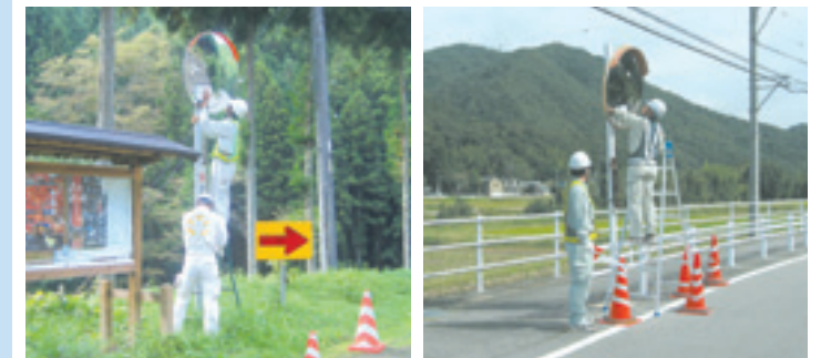
カーブミラー清掃の様子(豊田加茂建設事務所)
