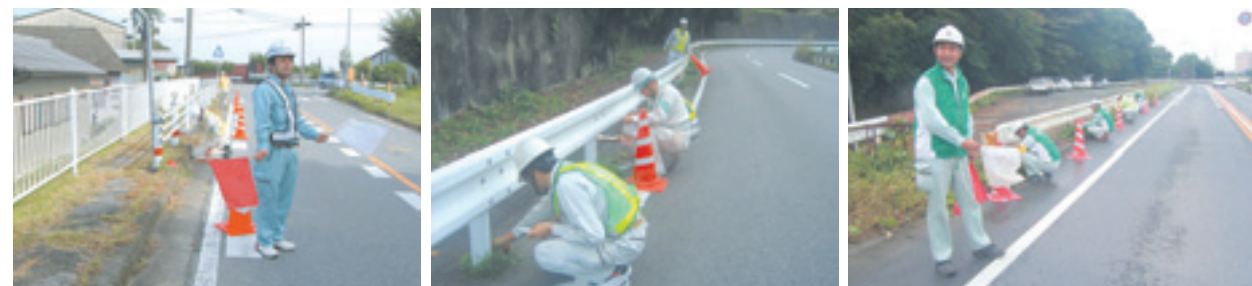
反射テープ貼付の様子(一宮建設事務所)
