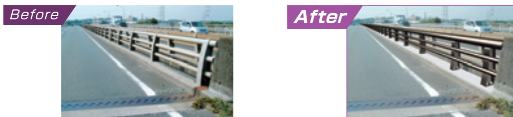
h. 車道部における橋梁防護柵でブロックアウト量が基準の数量を満たしていない場合
