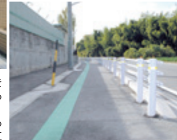
学校周辺であることを知らせる通学路カラー標示、子どもを車から守るガードパイプの施工
