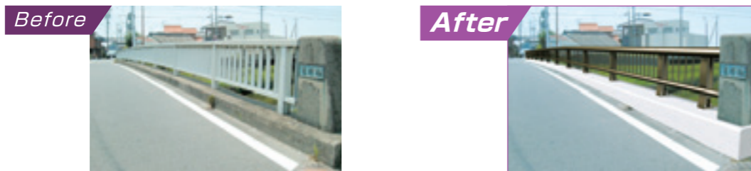
h. 車道部における橋梁防護柵でブロックアウト量が基準の数量を満たしていない場合
