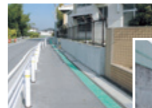
学校周辺であることを知らせる通学路カラー標示、子どもを車から守るガードパイプの施工
