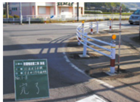
防護柵設置工事(完了後の様子)
