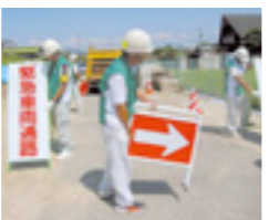
8月4日(火)実施 一宮・海部建設事務所管内
