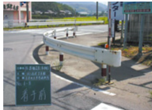
防護柵設置工事(着手前の様子)
