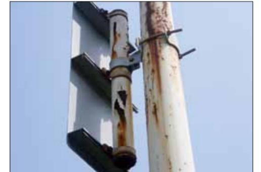
● 取付金具、補助支柱の錆が激しい。
