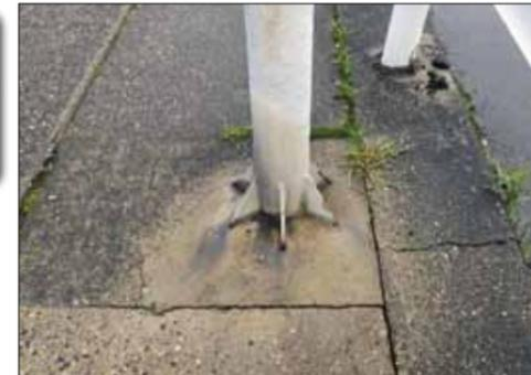
● 柱が老朽化かつ、プレートが露出している。
