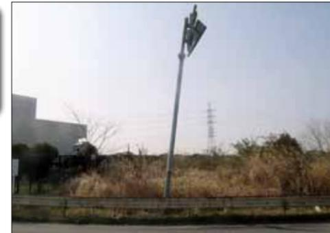
● 柱が破損して大きく傾いている。
