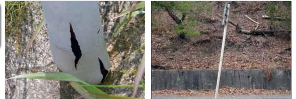
● 旧式の柱、塗膜が割れ錆が発生している。
