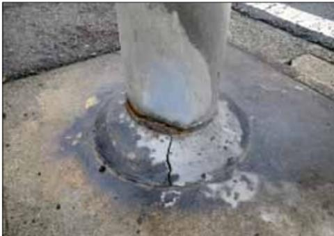
● 根巻きコンクリートが割れ、地際部の腐食部分は規定値の75%程度まで減少。
