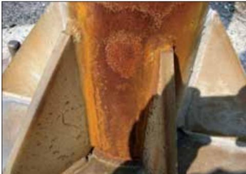
● 素地が露出し最も劣化が激しい状態。補強リブ付近は最も応力の集中する部分である。
