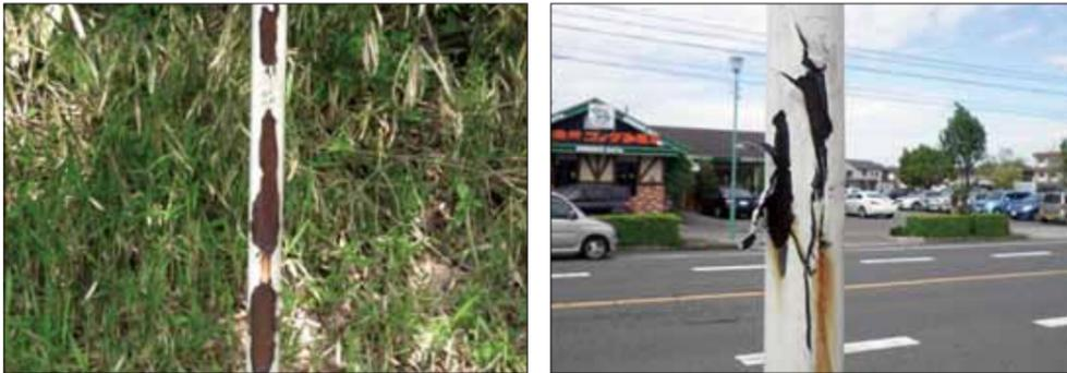
● 錆がかなり進行し、塗膜の亀裂が見られる。
