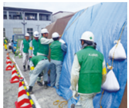
尾張建設事務所管内での訓練の様子
