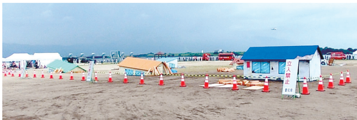
倒壊家屋に保安機材で立入禁止措置を完了
