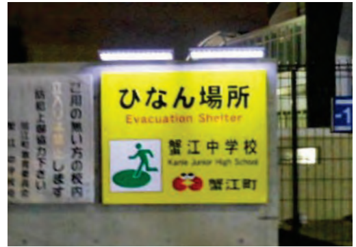
ソーラー照明式避難所標識
