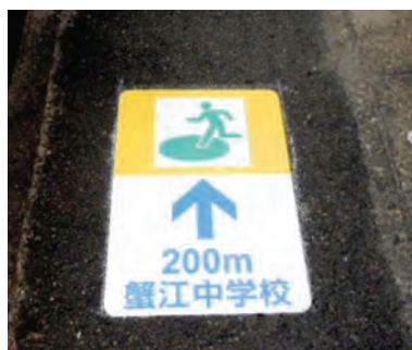
貼付式避難誘導シート
