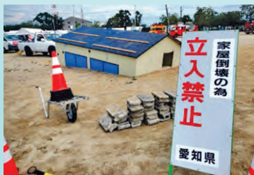
立入表示板設置完了
