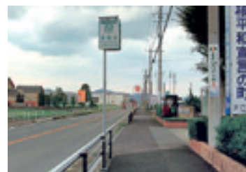
寄贈されたソーラー式避難誘導標識
