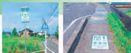
避難誘導標識 貼り付けシートと縁石鋲
