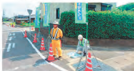
貼り付けシートの施工の様子
