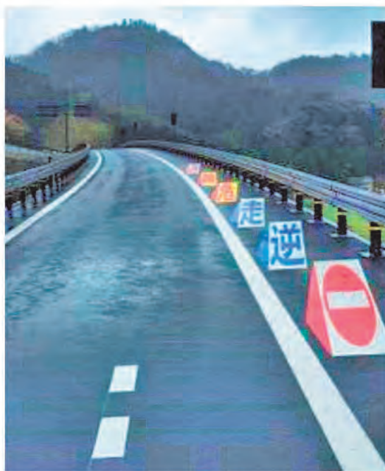
▲ 「逆送危険」の路面標示
