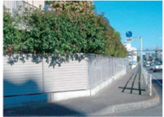
施工後 めかくし柵V型 H1500
