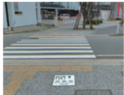
今回設置した 「避難路誘導路面シート」
