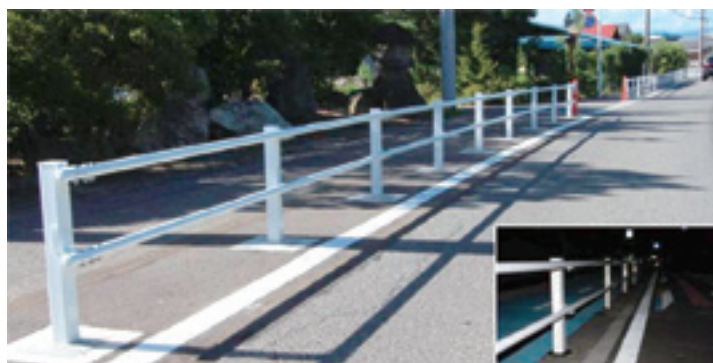
① スリムな構造で車両衝突を考慮した設計 (防護柵の設置基準・同解説準拠)
