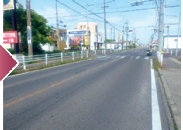
一般国道247号(西尾市一色町一色新田地内)
