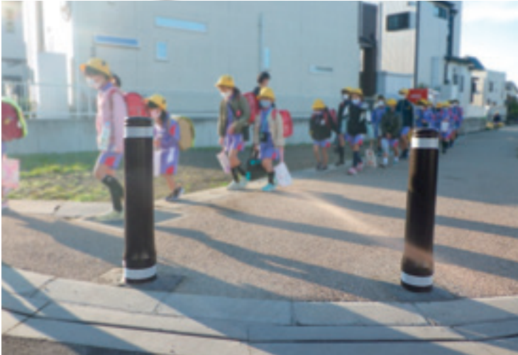
子どもたちを車両の侵入から守るために 交差点の歩道部に設置された「歩行者保護ポラード」
