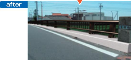
h. 車道部における橋梁防護柵でブロックアウト量が基準の数量を満たしていない場合
