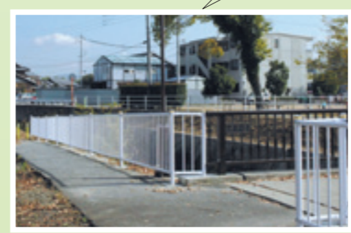
P.5 転落防止柵
