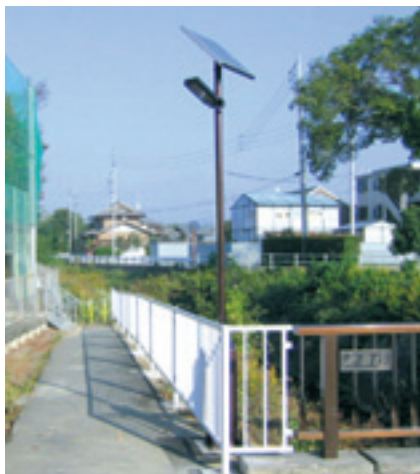
通学路に防犯灯としてLED照明灯を設置。災害時には誘導灯としても機能します。
