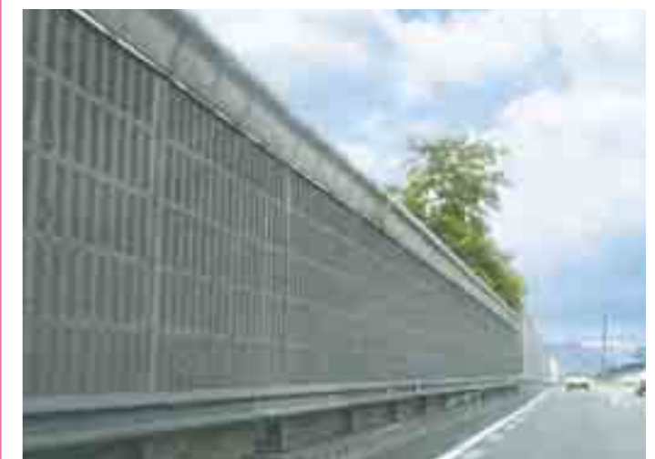
設置例：東名阪自動車道
