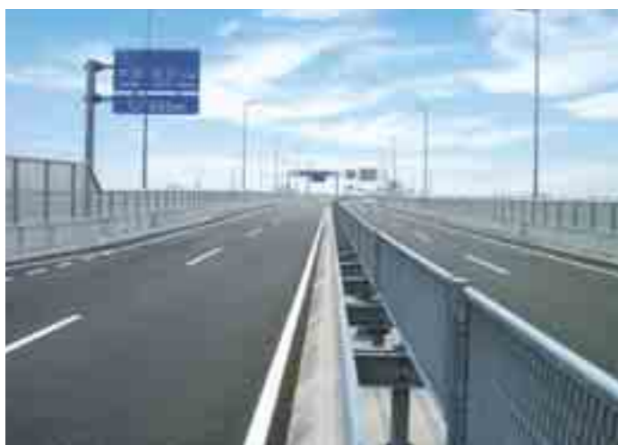
設置例：衣浦豊田道路
