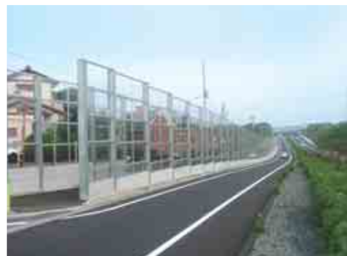
設置例：県道名古屋岡崎線
