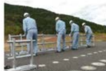
センターパイプ(部材取外し後)
