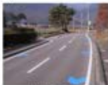
(矢羽根の設置)
