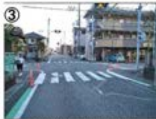
歩行空間整備 (カラー舗装)
