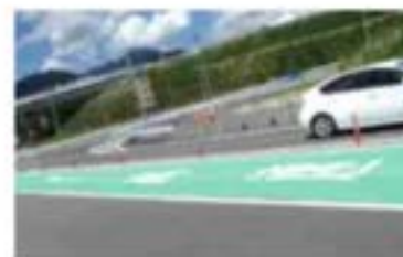
高速道路出入口部の対策 (カラー舗装)
