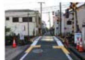
奈良県大和郡山形の手例 (歩道分離されていない道路での誘導用ブロック等の設置事例)
