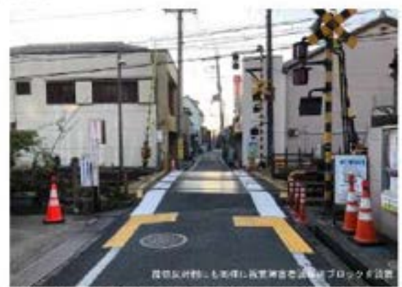
図 2-7-6 踏切道手前部に視覚障害者誘導用ブロックを設置した事例
