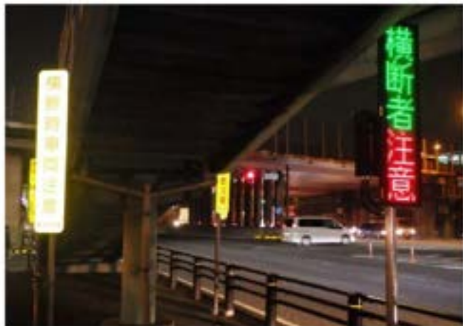
小牧市 名古屋国道 通学路左折巻き込み対策
