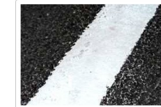
引き直したばかりの白線。塗料に混ざったガラスビーズが光を反射するため、夜間でも見やすい＝西宮市樋ノ口町2
