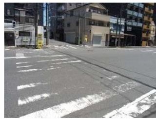
6割以上が消えている横断歩道を補修
