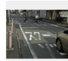
白線が薄くなった中央線や横断歩道 ＝横浜市神奈川区の市道で2023 年6月21日午後4時27分、柿崎 誠撮影
