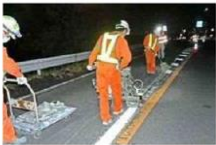
夜間に道路上の区画線を引き直す業者=西宮市樋ノ口町2
