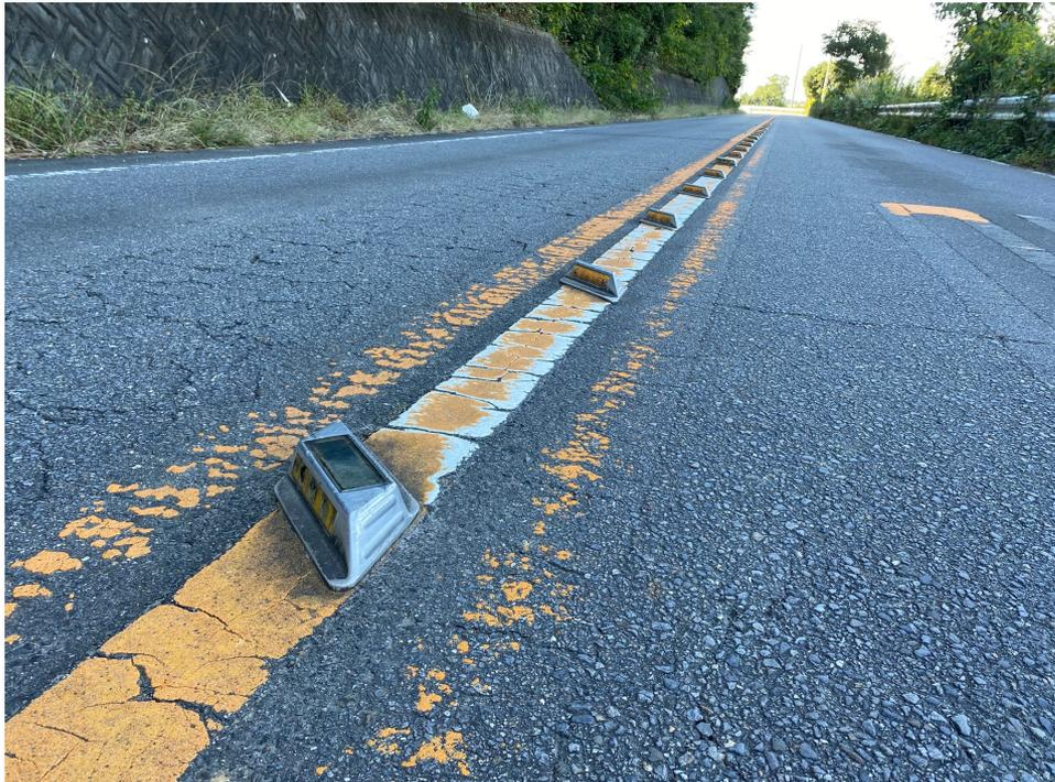
昭和から平成にかけて道路鋏(チャッターバー)はセンターラインのはみ出し防止の物理的デバイスとして県内各所に設置されており設置から既に30年近くが経過している。
